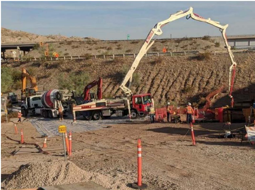
Concrete Slurry Mixture Pour at C9 South
