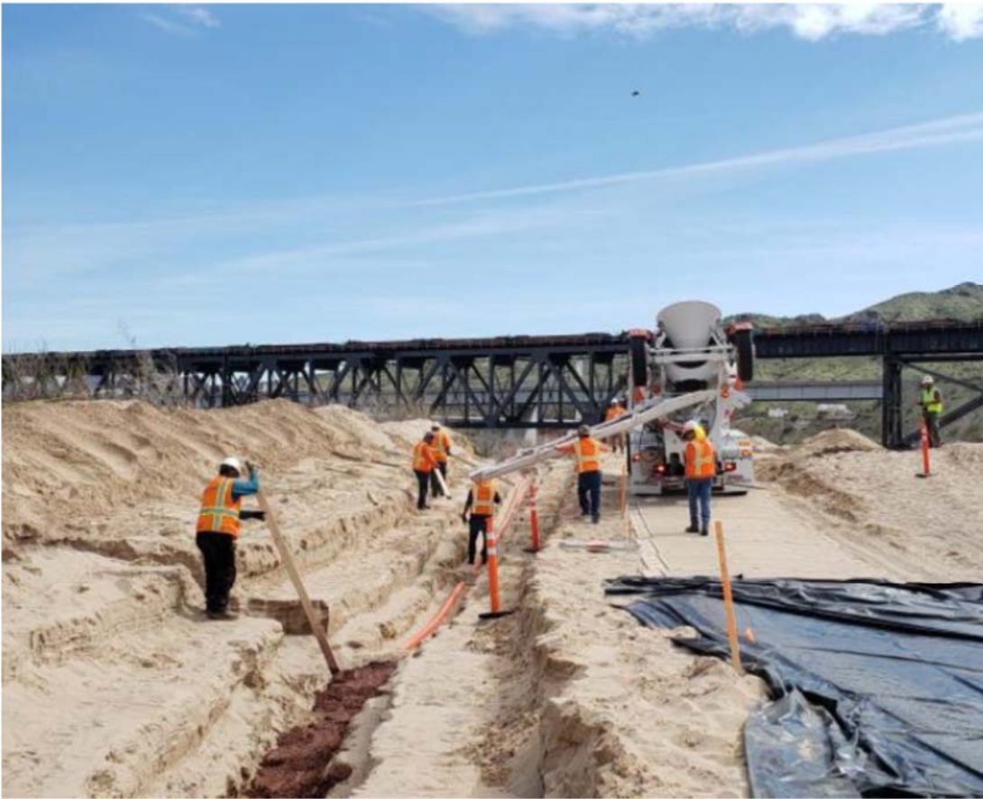
Concrete pour along Pipeline C5
